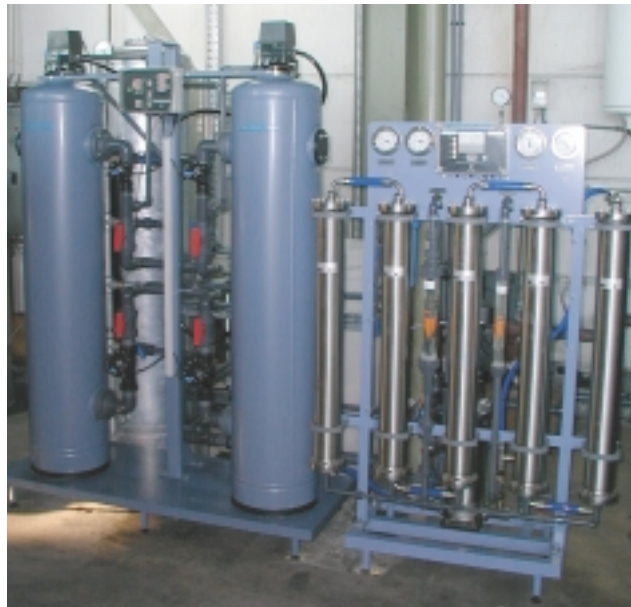
Figuur 34: Duplex ontharder en omgekeerde osmose voor de aanmaak van 2 m 3 /h ketelwater (bron: Eurowater).
