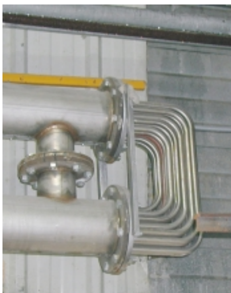
Figuur 10: Horizontaal opgestelde buis in buis warmtewisselaar in een end-of-pipe toepassing (bron: Dunlop).
